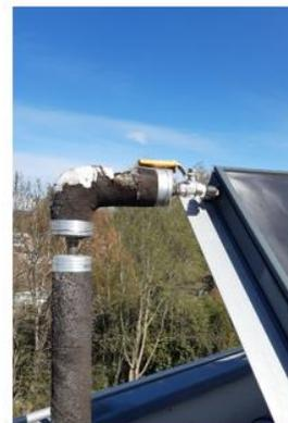
**La présence de vannes, sans dispositif de soupape, est interdite sur le réseau glycolé (capteurs-ballon solaire): risque de suppression capteurs = dégradation des tuyauteries**
