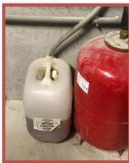
Surpression du réseau solaire (surchauffe capteur, défaut circulation, défaut sur le vase d'expansion) = ouverture de la soupape de sécurité
