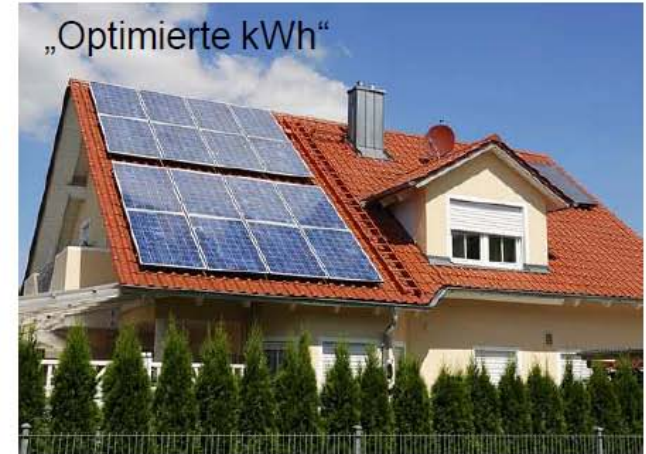
Adaptation de la production solaire à la consommation avec des toits orientés est/ouest
