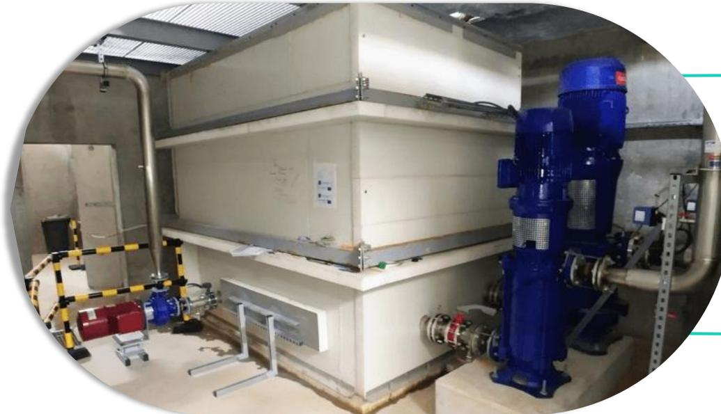
BATTERIE HYDRAULIQUE DE 15KW
