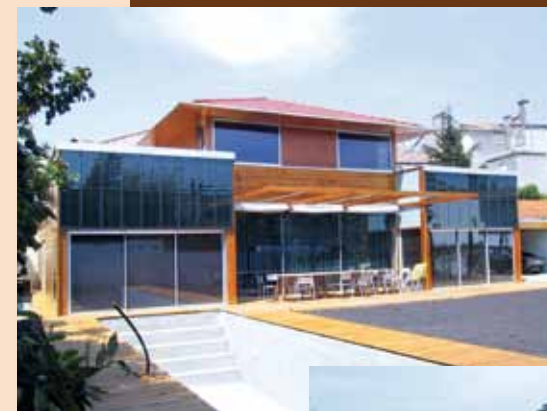
> Capteurs thermiques en façade (Chauffage)
