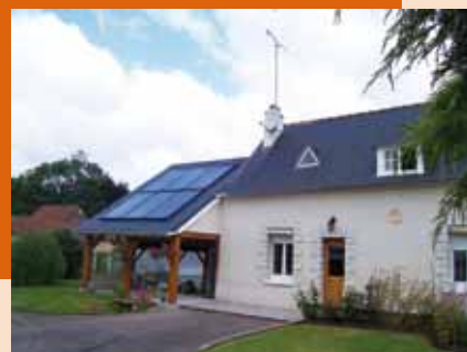
> Capteurs thermiques intégrés en toiture secondaire (Chauffage)
