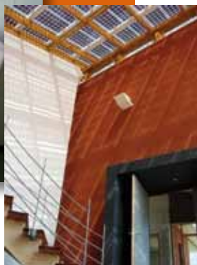
> Capteurs photovoltaïques semi-transparents en verrière
