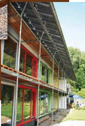
> Photovoltaïque en toiture avec auvent
