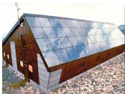
> Toiture complète en photovoltaïque
