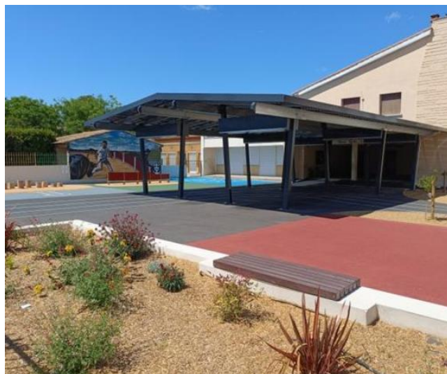
Préau solaire de 170 m 2 pour une école dans l'Hérault
